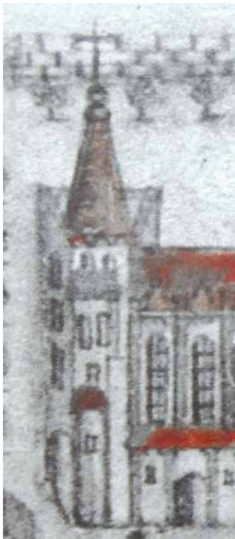
Il. 3. Wieża kościoła farnego od strony południowej na planie Georga Friedricha Rüdigers z ok. 1782–1792 (Muzeum Ziemi Chełmińskiej, fot. A. Soborska-Zielińska)
