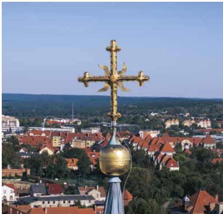
Il. 26. Krzyż wieńczący hełm wieży północnej kościoła farnego w Chełmnie, widok od strony zachodniej (fot. Sz. Zieliński)
